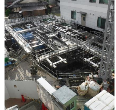
〈基礎・地中梁配筋工事〉
