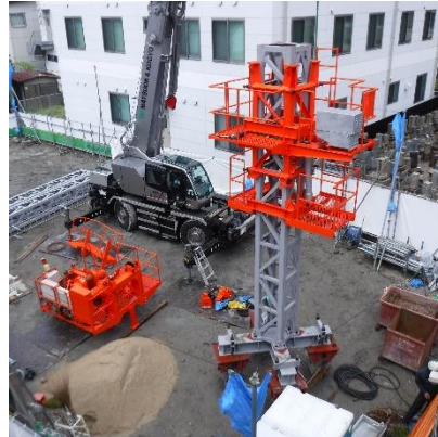
〈タワークレーン設置工事〉
